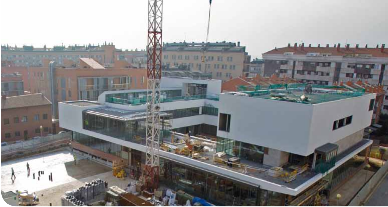
L'actual estat dels treballs de construcció de la nova biblioteca i centre cultural ja permeten fer-se una idea de com serà l'edifici
