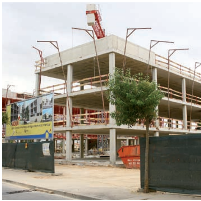
Habitatges de lloguer a l'avinguda Generalitat, ja en construcció
