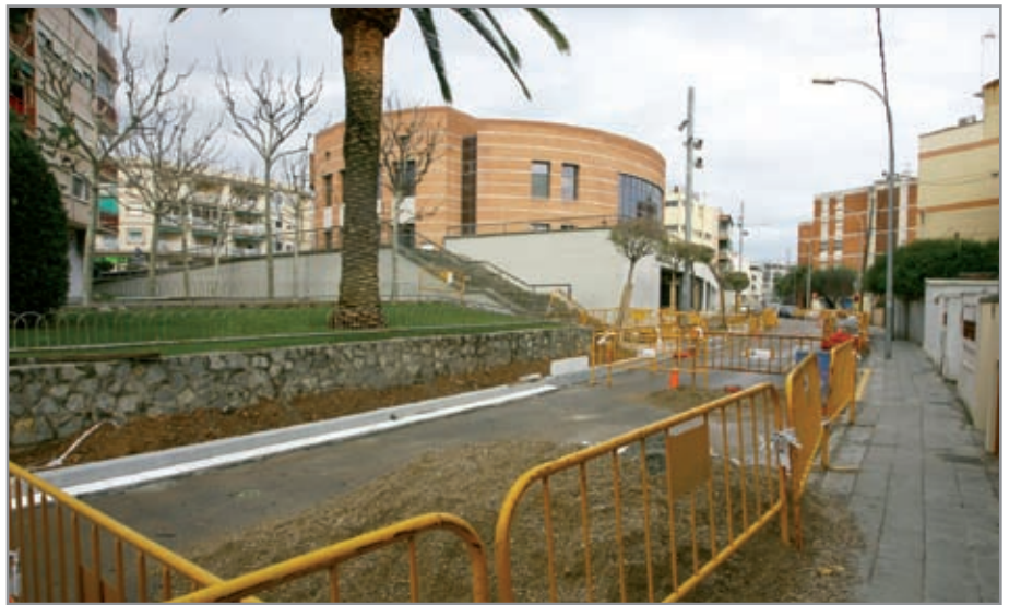
Ya han comenzado los trabajos de remodelación de la calle Sant Francesc d'Assís, una de las obras contempladas en el proyecto de la Ley de Barrios de Les Planes
