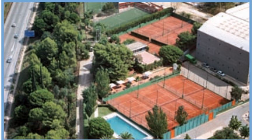
A dalt, imatges històriques, la de la dreta amb el molí al fons. Sota aquestes línies, les instal·lacions actuals
