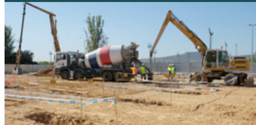
65 pisos de alquiler, calle Torreblanca
