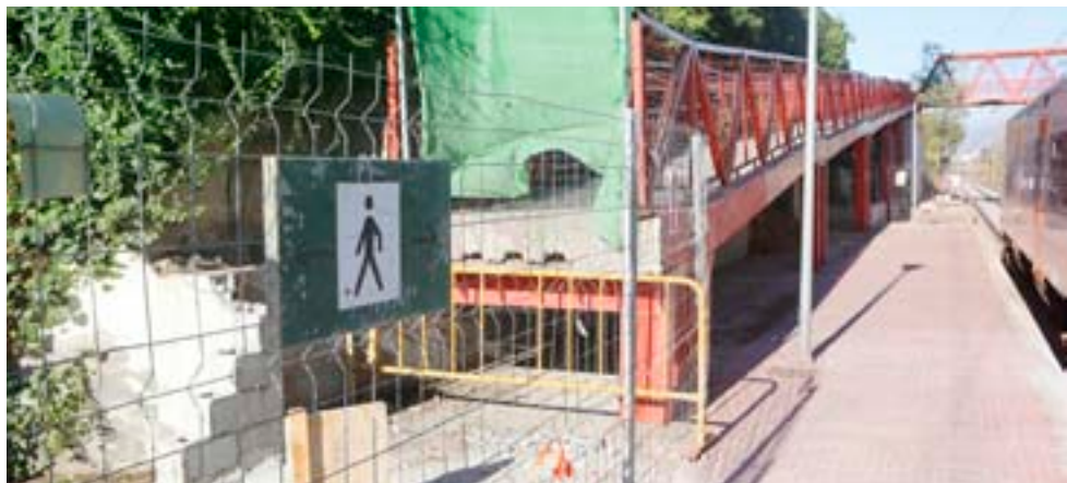
A la fotografia superior s'observen el nou paviment i els fanals de leds, més eficients, que s'han instal·lat al passeig del Canal (a la petita, detall del fanal). A sota, la rampa de l'estació, tancada
