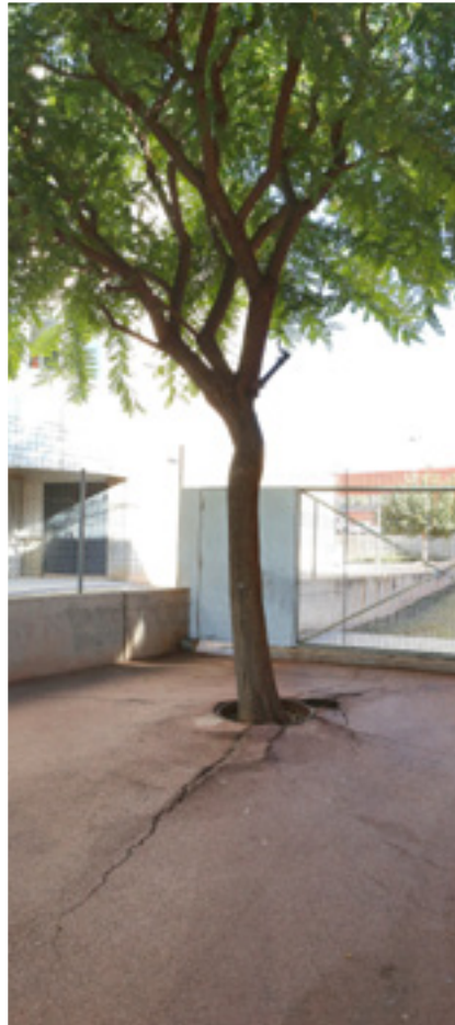
A dalt, imatge dels actuals fanals que se substituiran per uns de leds al passeig del Canal. A l'esquerra i sota, els desperfectes que han provocat al llarg dels anys les arrels d'alguns dels arbres d'aquest tram del passeig
