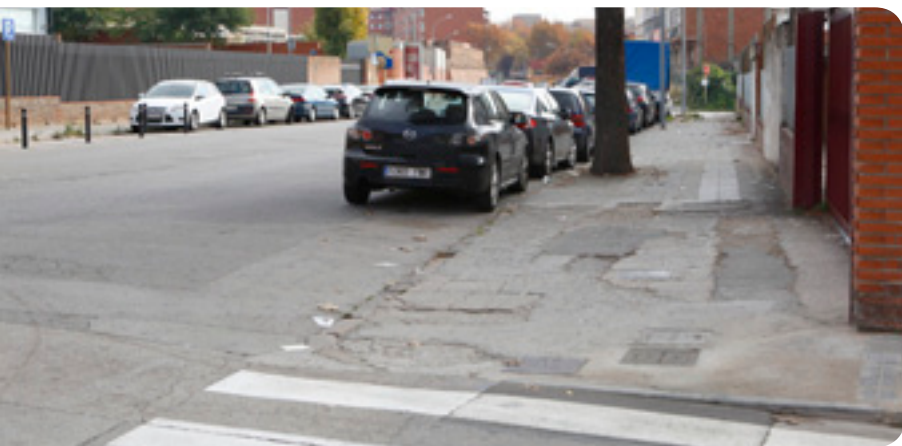
Detall d'una de les voreres de Mare de Déu de Montserrat que es repararà
