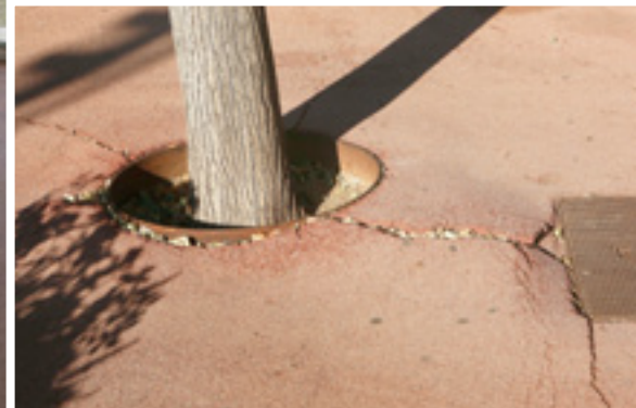
A dalt, imatge dels actuals fanals que se substituiran per uns de leds al passeig del Canal. A l'esquerra i sota, els desperfectes que han provocat al llarg dels anys les arrels d'alguns dels arbres d'aquest tram del passeig
