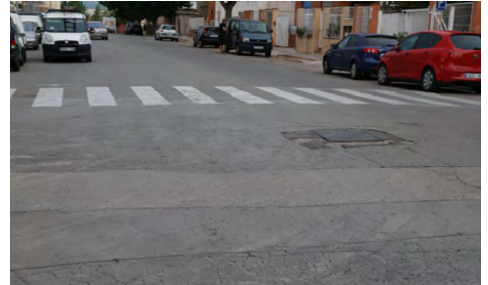
Las obras mejorarán las condiciones de conducción y la conservación de calles como la de la imagen, Mare de Déu de Montserrat, en la zona industrial de la ciudad
