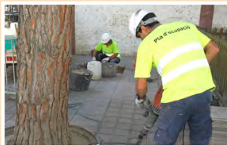
L'Ajuntament seguirà realitzant programes per a la dinamització econòmica i la generació de llocs de treball a la ciutat, ja sigui a través de col·laboracions amb les empreses, l'obra pública o l'oferta de plans d'ocupació (a la foto, treballadors d'un d'aquests plans, realitzant obres de reposició a la plaça de l'Ermita).
