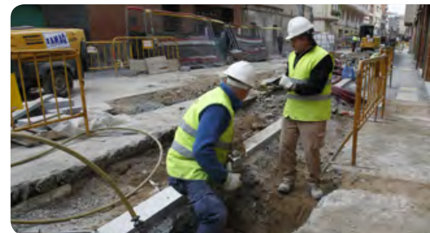
Obras de reforma en la calle Frederic Casas, entre Catalunya y Major
