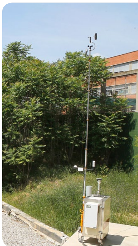
Dispositivo instalado en el Área de Serveis
