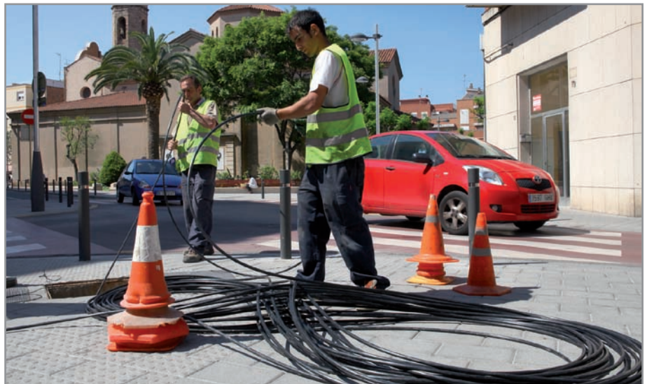
Operarios instalando la fibra óptica en la calle Jacint Verdaguer esquina con Catalunya
