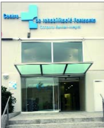
Instal·lacions del centre de rehabilitació, situat al número 22 de l'avinguda de la Font Santa, davant la parada del Tramvia
