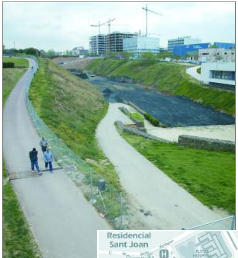
En la imagen superior se observa como el relleno comienza a subir la cota del desnivel. En los primeros trabajos se utiliza la pizarra (de ahí el tono oscuro que se aprecia en la imagen), un material que facilita la compactación del terreno. La imagen de la derecha muestra el ámbito del parque (en color verde) que será remodelado
