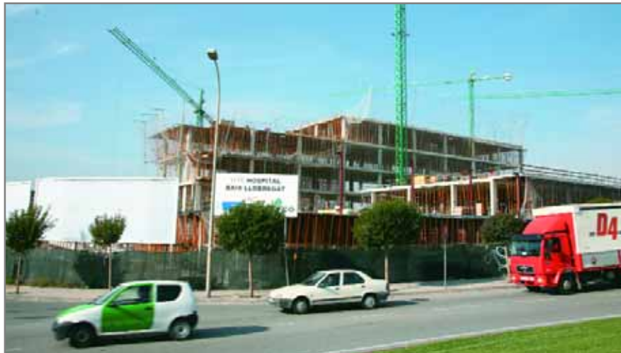
L'edifici, que tindrà una gran zona verda al costat, ja ha aixecat l'estructura
