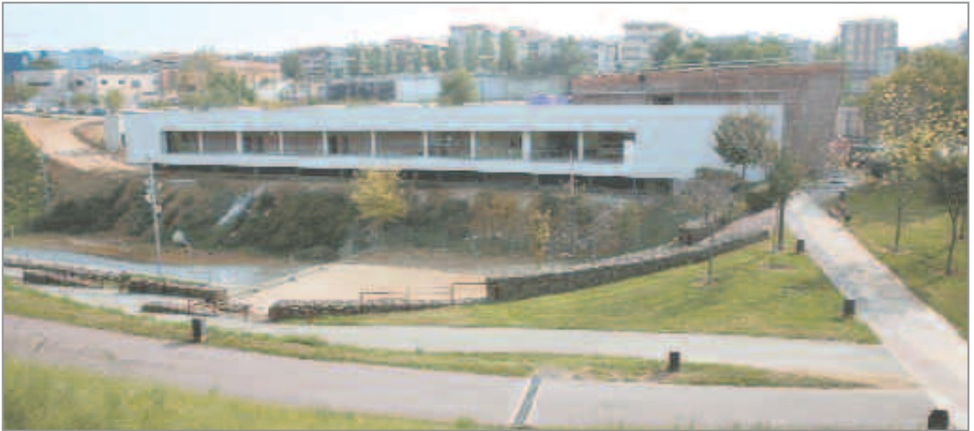
Les obres de la nova escola bressol municipal El Gegant del Pi han entrat ja a la recta final, com es pot veure a la imatge superior
