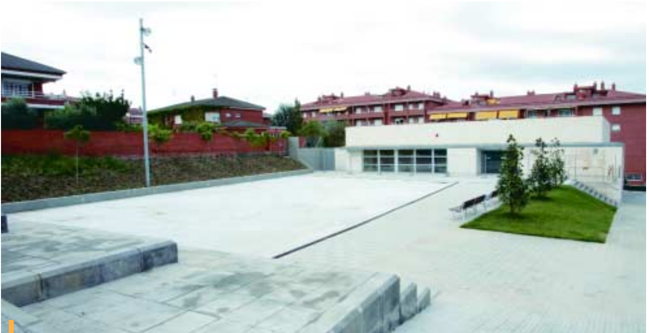
La construcció del nou equipament cívic ha dotat el barri d'una nova plaça, que ja està enllestida
