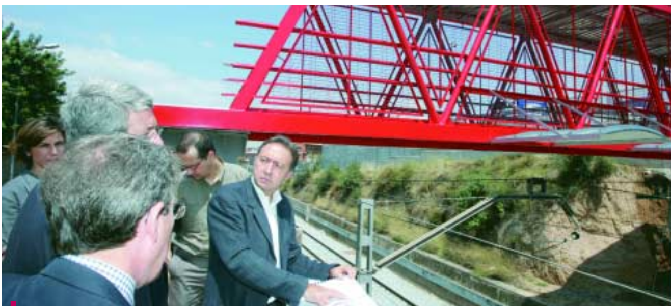
El primer tinent d'alcalde, Antoni Poveda, durant una visita a les obres, acompanyat de José Juan Ortega, cap de supressió dels passos a nivell de Renfe, i Antonio Díaz de Lope, president de Socran, l'empresa constructora
