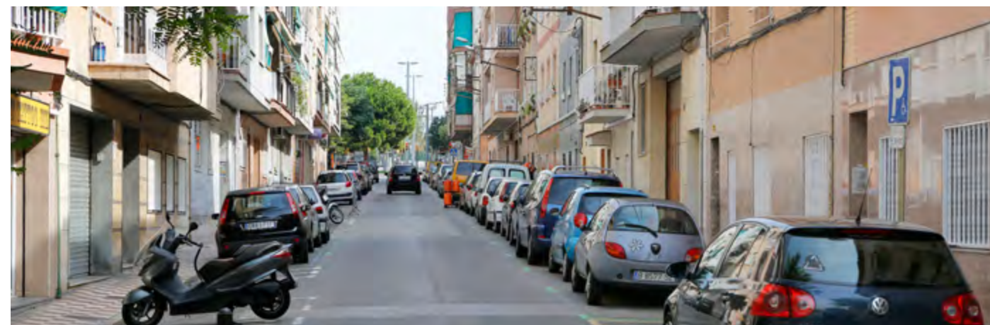
Estado actual de un tramo de la calle Montilla, en el barrio de Les Planes
