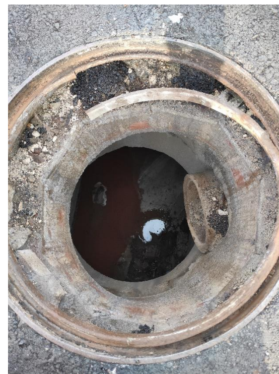
Figura 10. Vista interior del pou de registre PR256
