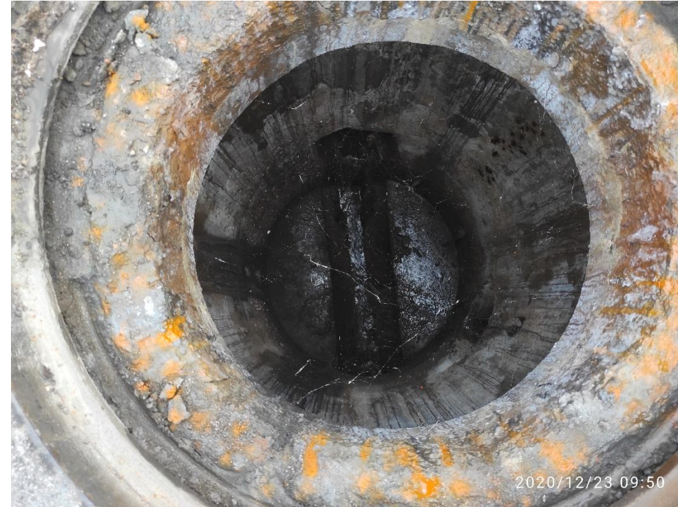
Figura 14. Vista interior del pou de registre PR288
