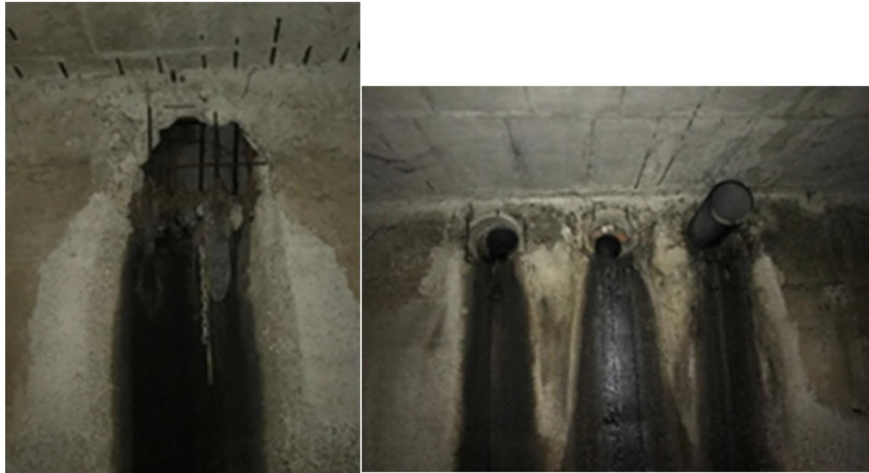
Figura 3 (esquerra). Connexió de xarxa pluvial sense clapeta
