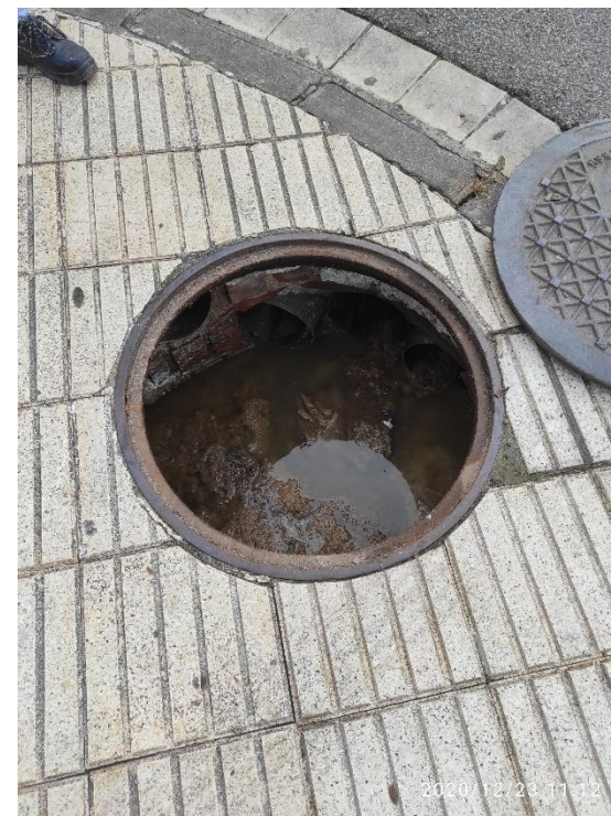
Figura 11. Vista interior del pou de registre PR374 i dels 3 tubs que es connecten al col·lector de la Riera d'en Nofre
