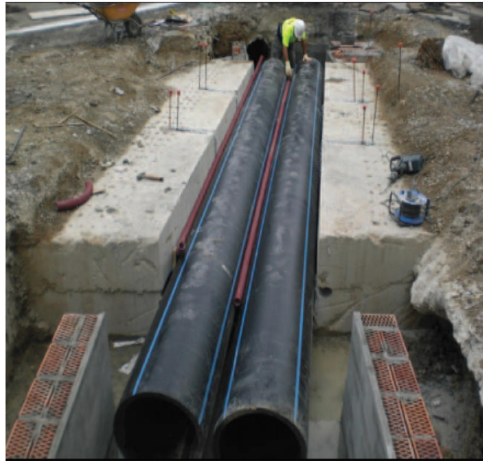
Figura 10 (esquerra). Obres de By-pass al 2012 a l'alçada del Carrer del Camí del mig
