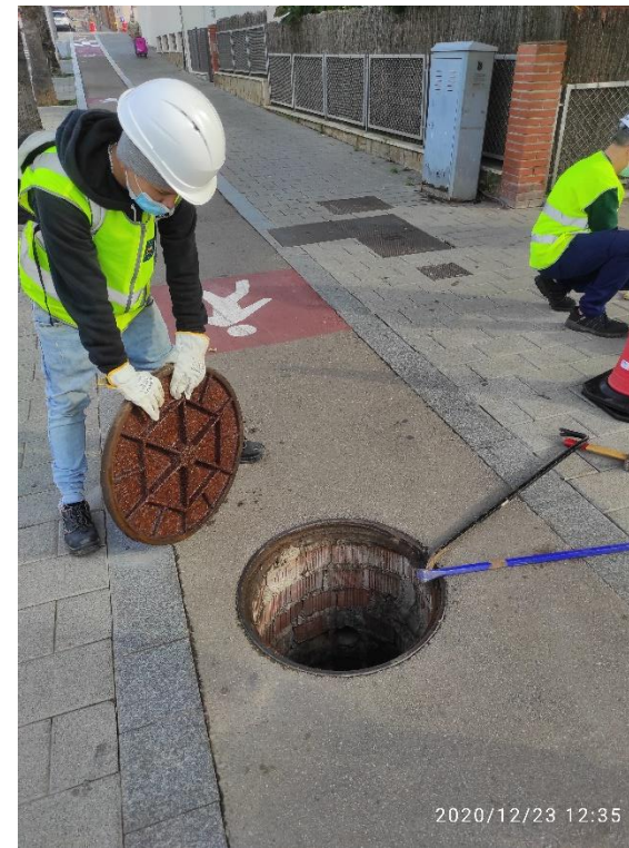
Figura 6. Pou de registre PR267 obert al carrer de la Creu d'en Muntaner a l'altura del Passeig Canal
