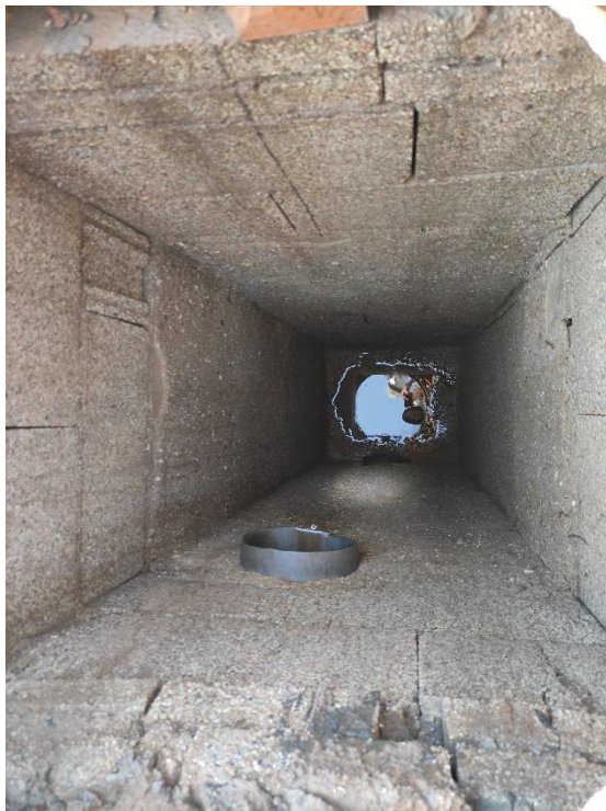
Figura 13. Vista interior del pou de registre PR235
