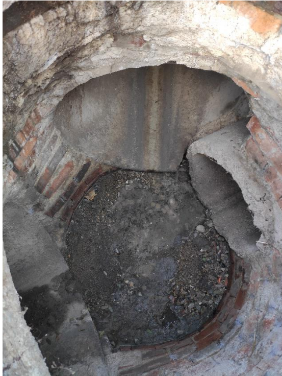
Figura 12. Vista interior del pou de registre PR373
