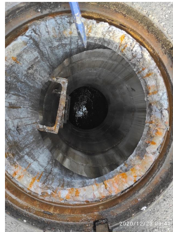
Figura 15. Vista interior del pou de registre PR286
