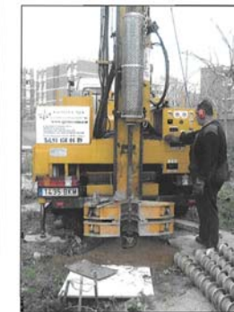
Realització d'un assaig SPT
