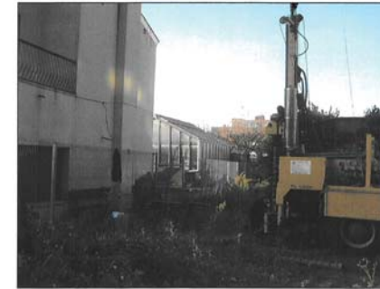
Treballs de perforació del sondeig de reconeixement S-1
