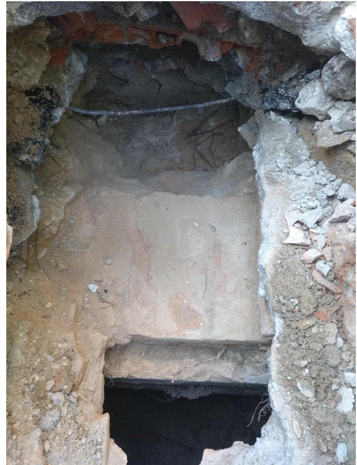
02-Situació del mur del canal
