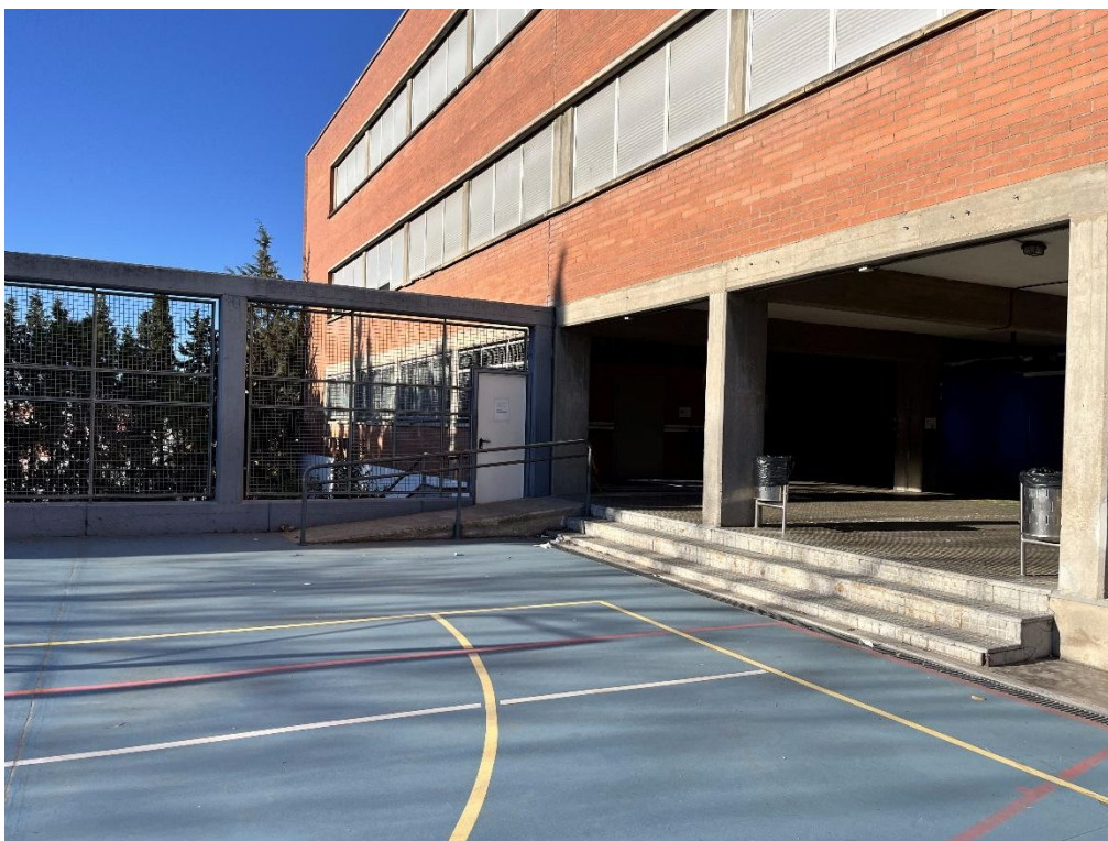
Rampa accés pista esportiva-1
