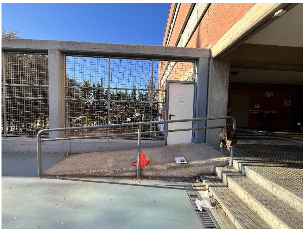
Rampa accés pista esportiva-2
