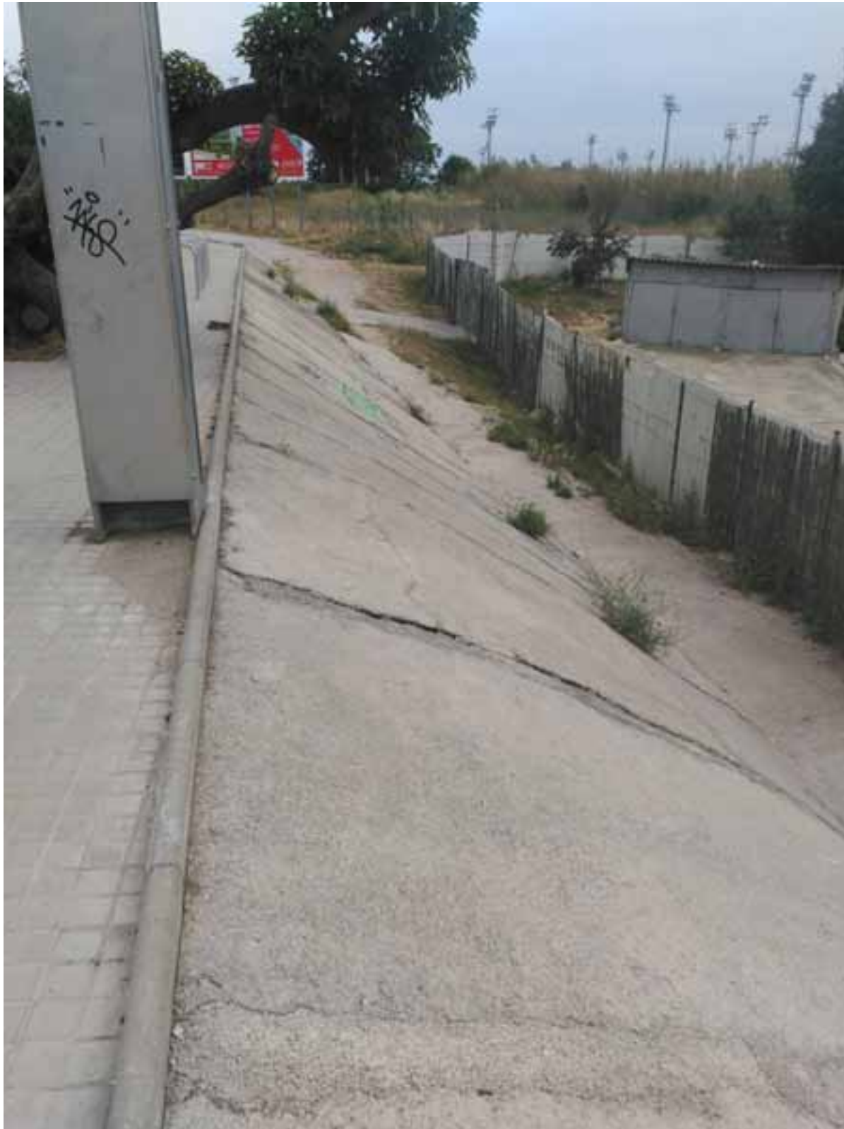
Fotografia núm.3. Estat actual del talús.
