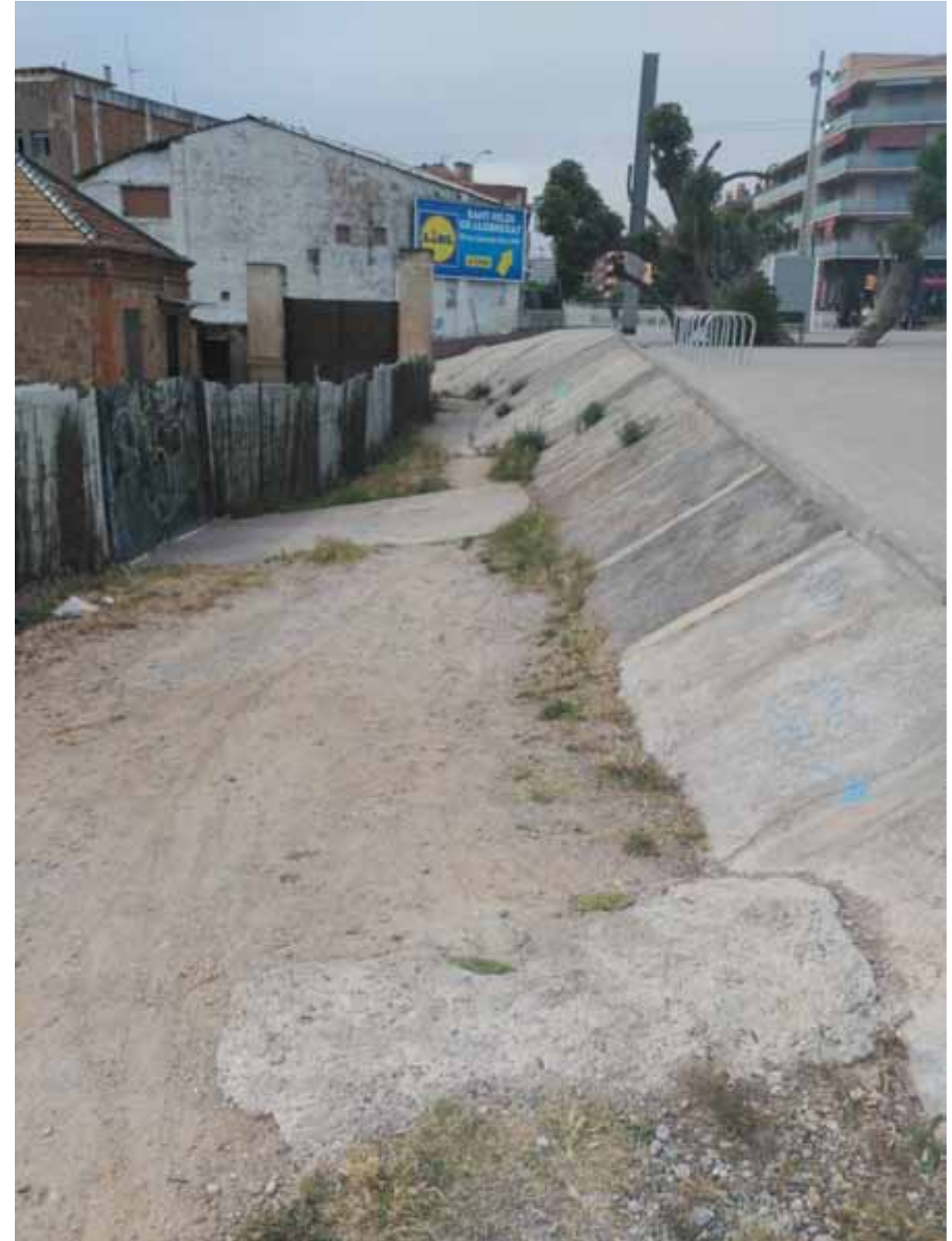
Fotografia núm.2. Estat actual del talús.
