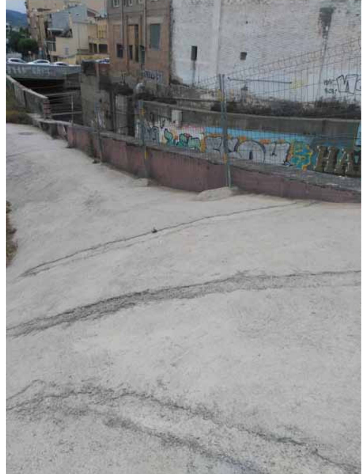
Fotografia núm.8. Estat actual del mur costat riera Pahissa.
