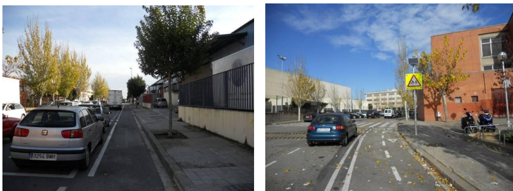
Fig. 34. Carril bici entre la línia d'aparcament i la vorera a l'av. de la Generalitat i al c. Sant Martí de l'Erm.
