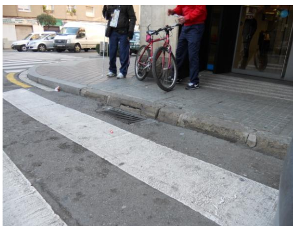
Fig. 32. Inexistència de gual al barri de les Planes: cruïlla c. Mare de Déu de la Mercè – c. Àngel Guimerà Font: elaboració pròpia
