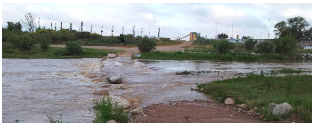
Fig. 48. Passera inundable sobre el riu Llobregat.
