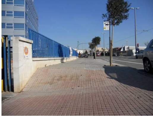
Fig. 30. Vorera amb pendent molt elevat. Font: elaboració pròpia
