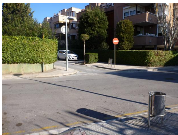
Fig. 36. Inexistència de guals a l'av. del Pla del Vent i falta de passos de vianants al c. de Sant Jordi. Font: elaboració pròpia
