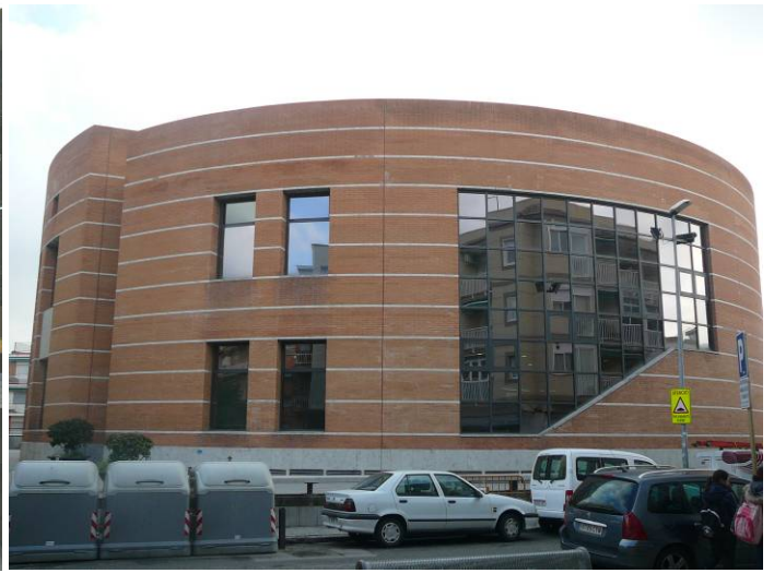
Figura 2. Façana circular de l'equipament.
