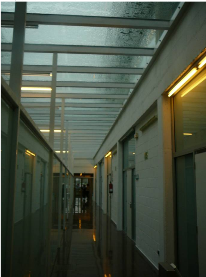
Figura 3. Lluerna sobre passadís d'accés principal.
