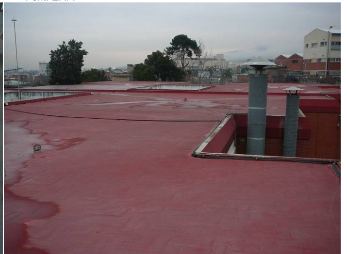
Figura 4 Coberta de l'edifici principal.
