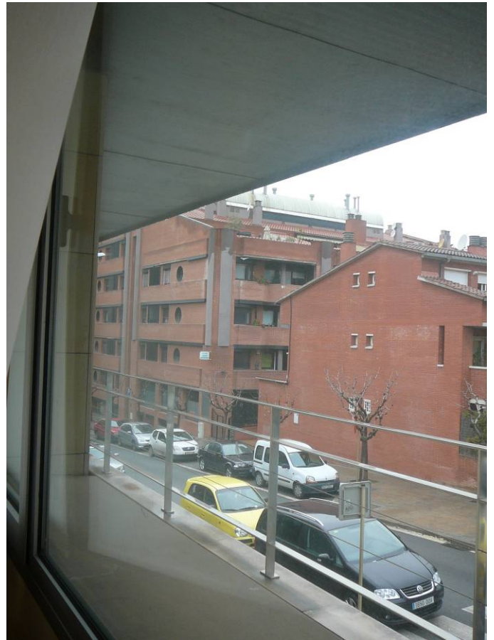
Figura 2. Tancament practicable amb ràfec de protecció solar.
