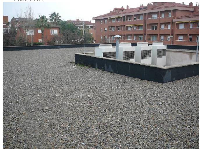
Figura 4. Coberta i equips centralitzats de climatització.
