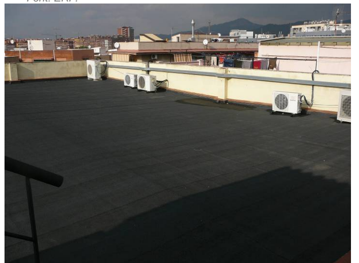
Figura 4. Coberta amb sistemes de climatització individual, tipus split.
