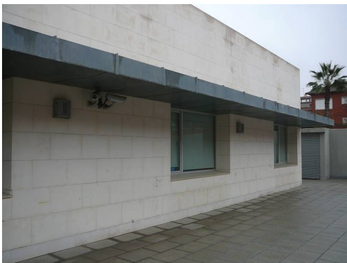
Figura 3. Ràfec de protecció solar.
