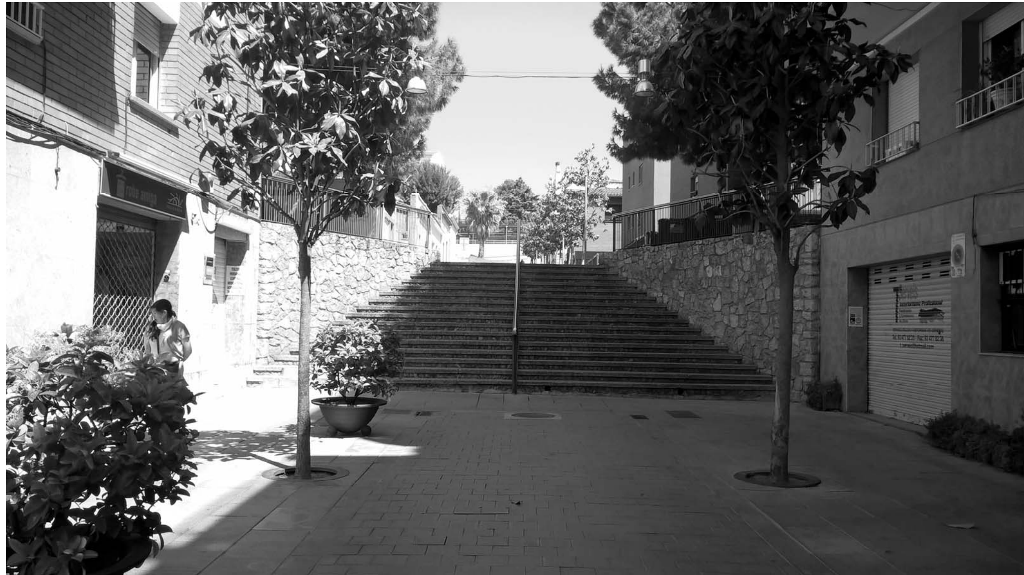
PROJECTE EXECUTIU DE REURBANITZACIÓ I MILLORA DE L'ACCESSIBILITAT DEL CARRER BALTASAR D'ESPANYA A SANT JOAN DESPÍ Desembre 2017
