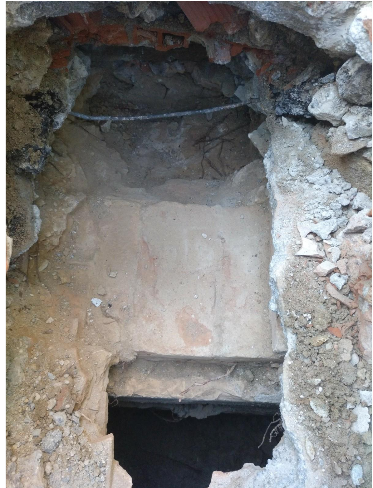
02-Situació del mur del canal
